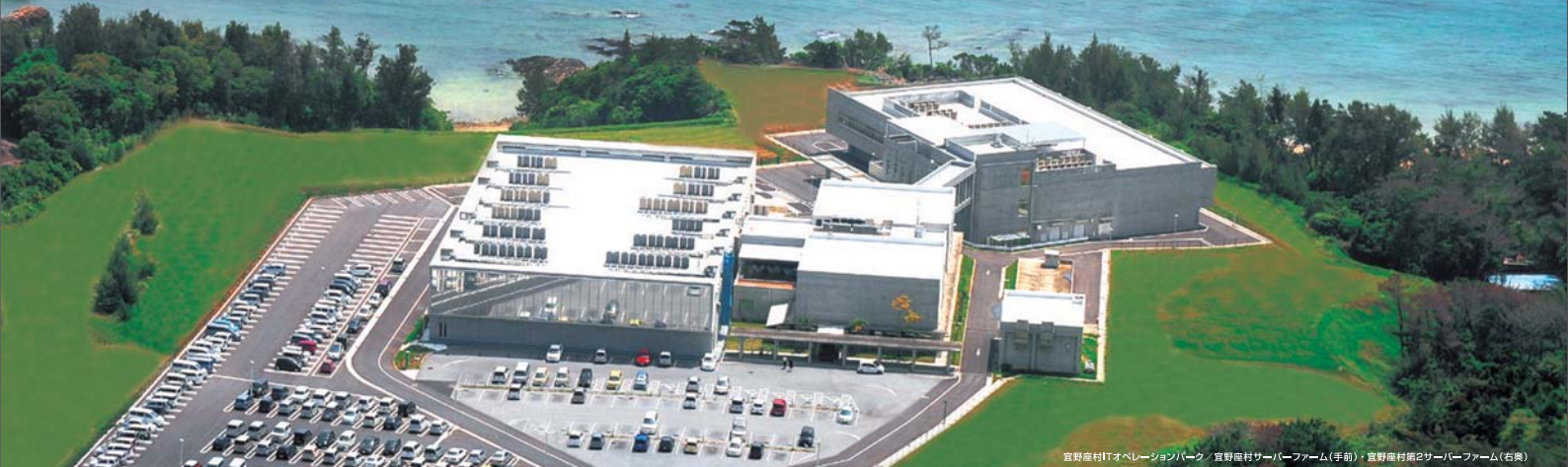
宜野座村ITオペレーションパーク / 宜野座村サーバーム(手前) / 宜野座村2号サーバーム(右奥)
